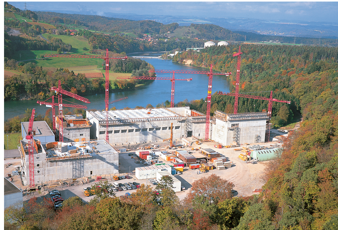
Bau des Zwischenlagers Würenlingen Foto: ZWILAG
